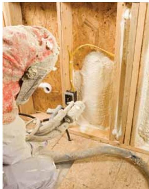
取得数据的标准环境条件: 喷涂泡沫 25 - 27 kg/m<sup>3</sup> (1.56 - 1.69 lb/ft<sup>3</sup>), 未使用通风。异氰酸酯喷涂要求使用通风。
