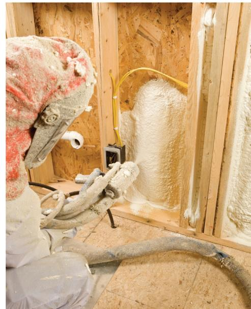
Os dados de amostra abaixo foram obtidos de espuma nominal 25–27 kg/m³ (1.56–1.69 lb/cu³) sem uso de ventilação. A ventilação é um requisito para a utilização de isocianatos.
